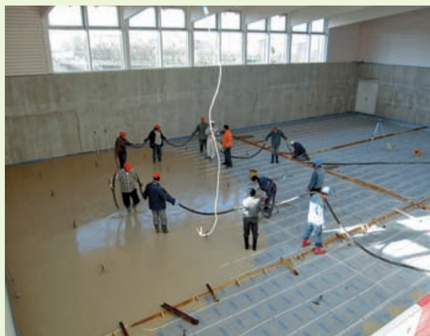
Giessen des Unterlagsbodens in der Turnhalle und den Klassenzimmern.
