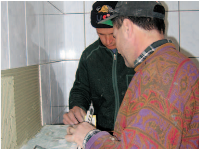
Fliesenlegen. Genaues Arbeiten ist gefragt.
